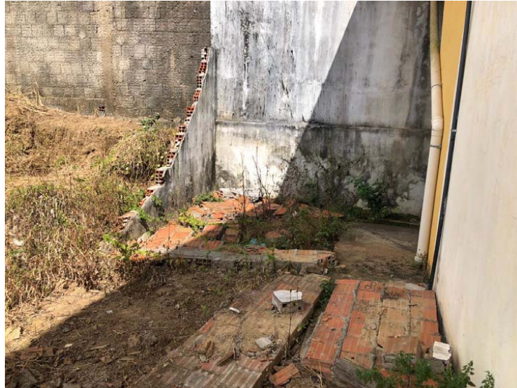
Imagem 6 – Demolição do muro da quadra.
