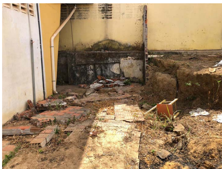
Imagem 5 – Demolição do muro da quadra.
