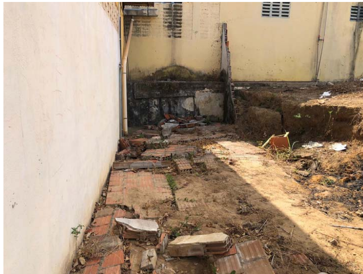
Imagem 7 – Demolição do muro da quadra.
