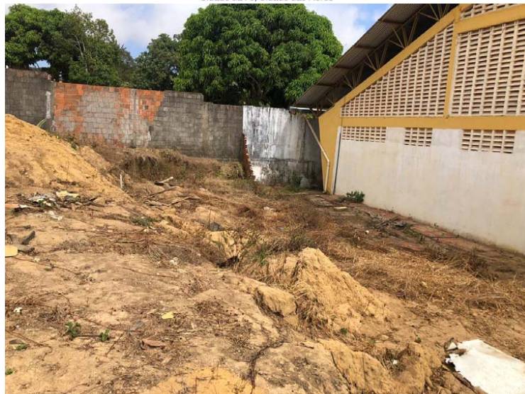
Imagem 4 – Demolição do muro da quadra.
