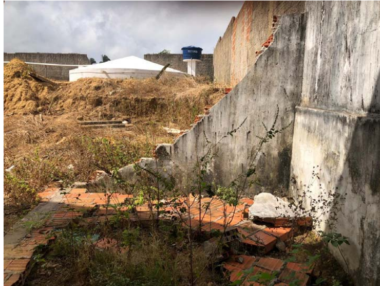
Imagem 2 – Demolição do muro da quadra.
