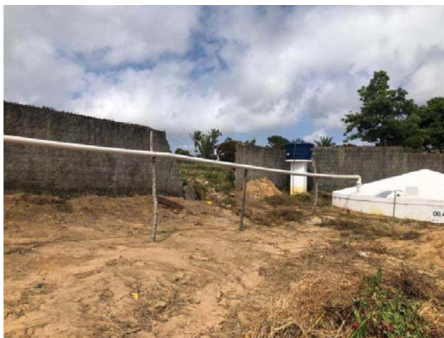
Imagem 1 – Demolição do muro para colocação da cisterna.
