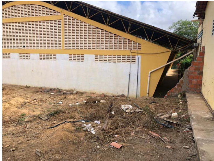
Imagem 3 – Demolição do muro da quadra.
