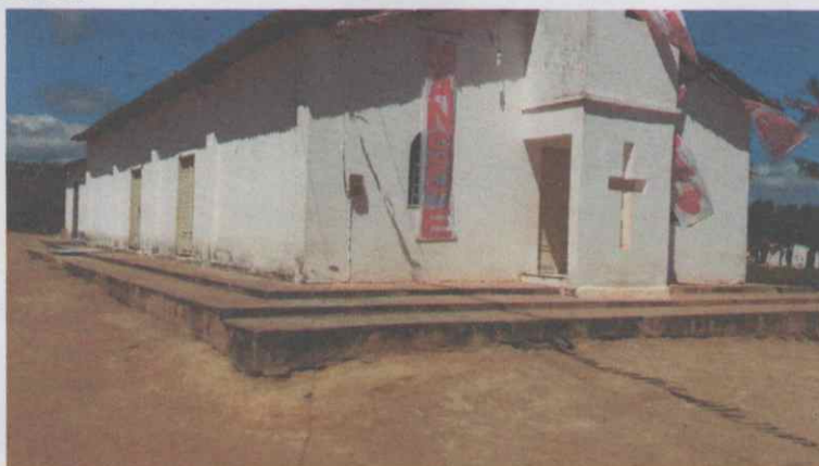
Imagem 1 – Imagem do local onde será construída a Praça do Xique Xique.
