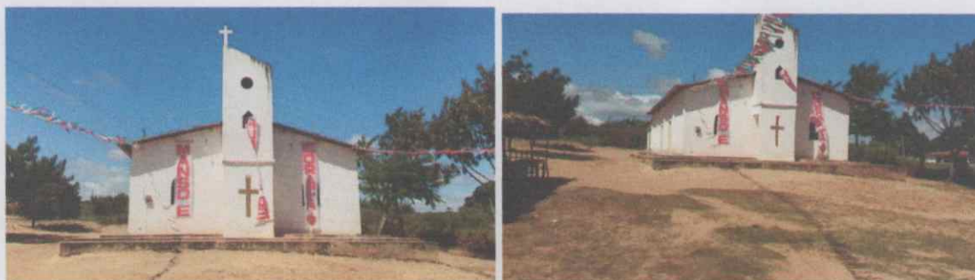
Imagem 2 – Imagem do local onde será construída a Praça do Xique Xique.
