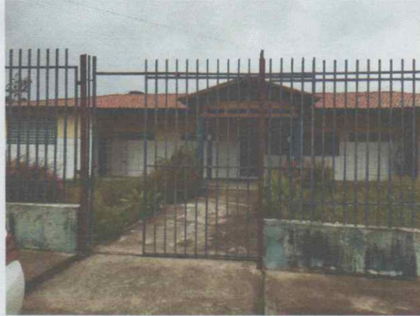
Imagem 2 – Fachada da escola
