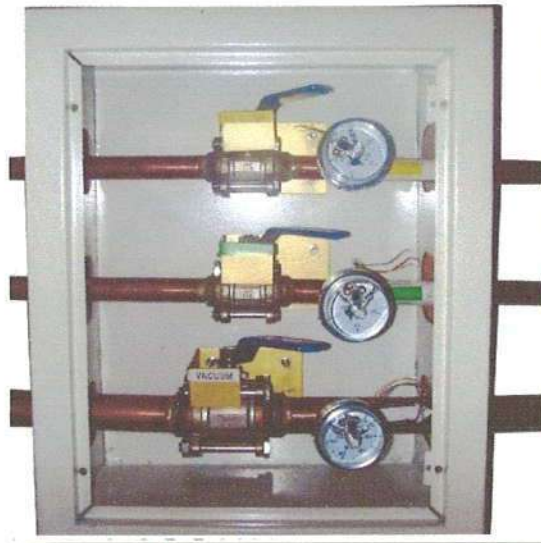
Figura 4 – Caixa de proteção para válvula de seção da rede de gases. Instalação em local estratégico.
