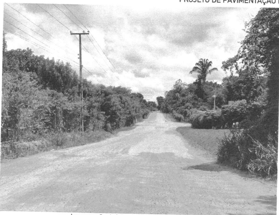
Imagem 2 - Início do Trecho 1 (Estaca 0)
