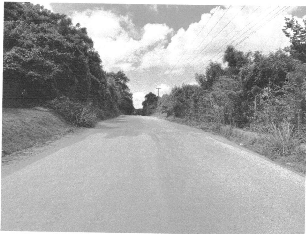
Imagem 1 - Início do Trecho 1 (Estaca 0)
