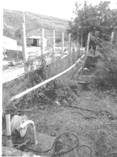
Figura 4.2 - Execução do teste de bombeamento no poço PT 01, existente em Sitio Pau D'arco II, São Benedito- CE.
