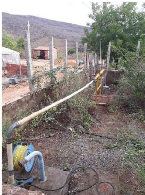
Figura 4.2 - Execução do teste de bombeamento no poço PT 01, existente em Sítio Pau D'arco II, São Benedito- CE.
