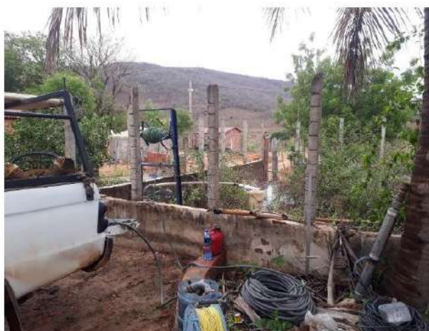
Figura 4.1 - Execução de limpeza e desenvolvimento no poço PT 01, existente em Sítio Pau D’arco II, São Benedito - CE.
